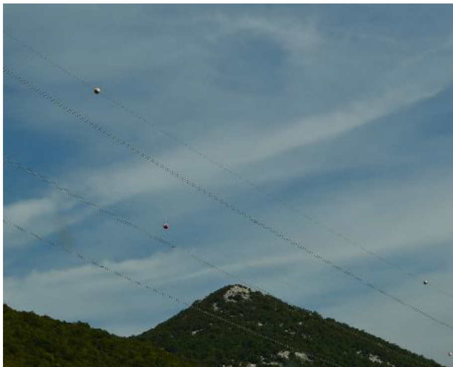
Slika A-3-1. Označavanje kablova i žica kuglama
